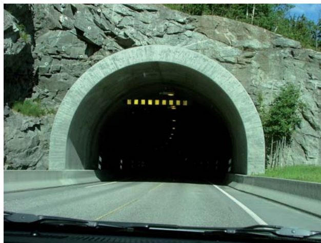
Tunnelmynning med bågformad betongport i bergvägg. Exempel från Norge.
