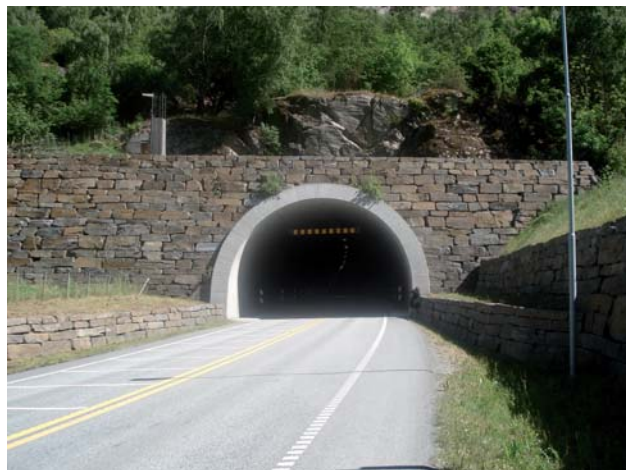
Tunnelmynning med murad bakgrund och gjuten port. Exempel från Norge.
