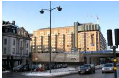
Figur 7, Cykelgarage under Klarabergsgatan, Jernhusen (2009-12-10)
