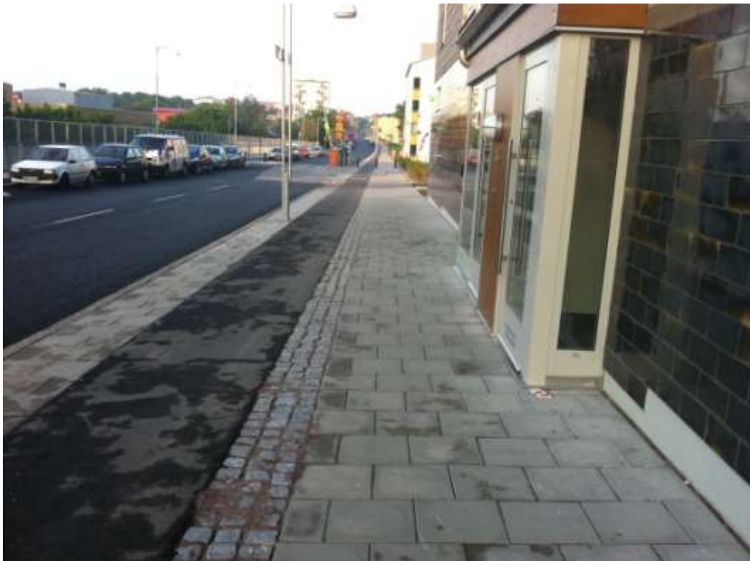
Bild 2: Entré vid Hägerstensvägen port 235 A-B
