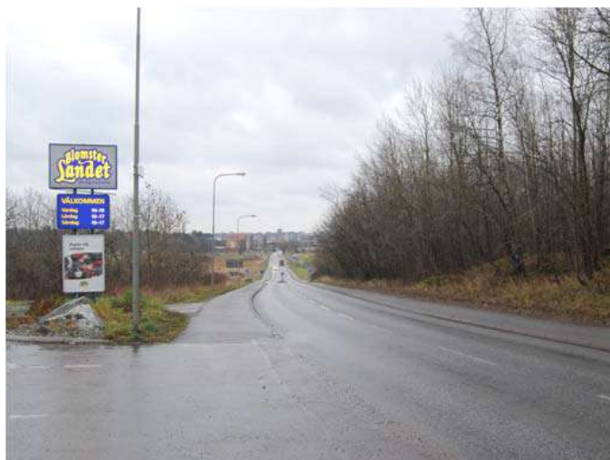
Figur 4. Bild över befintlig sektion mellan Doktor Abrahams väg och Travbanevägen
