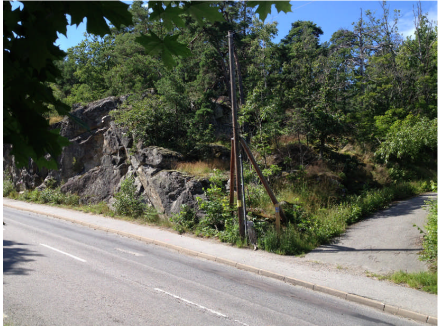
Gång- och cykelvägen sedd från söder med Brakmarsvägen och den sprängda bergknallen i förgrunden.
