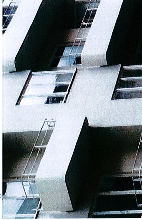
Referens på balkonger med överliggare vid burspråk
