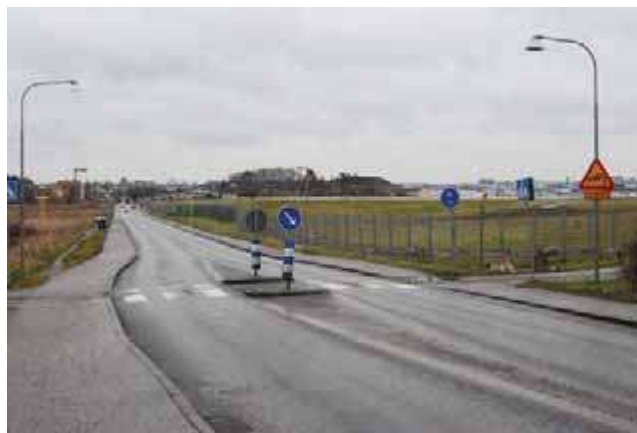
Figur 7. Övergångsstället vid flygrakan i riktning mot Gamla Bromstensvägen
