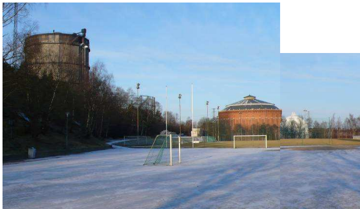
Foto över dalstråket med gasklockan i fonden
