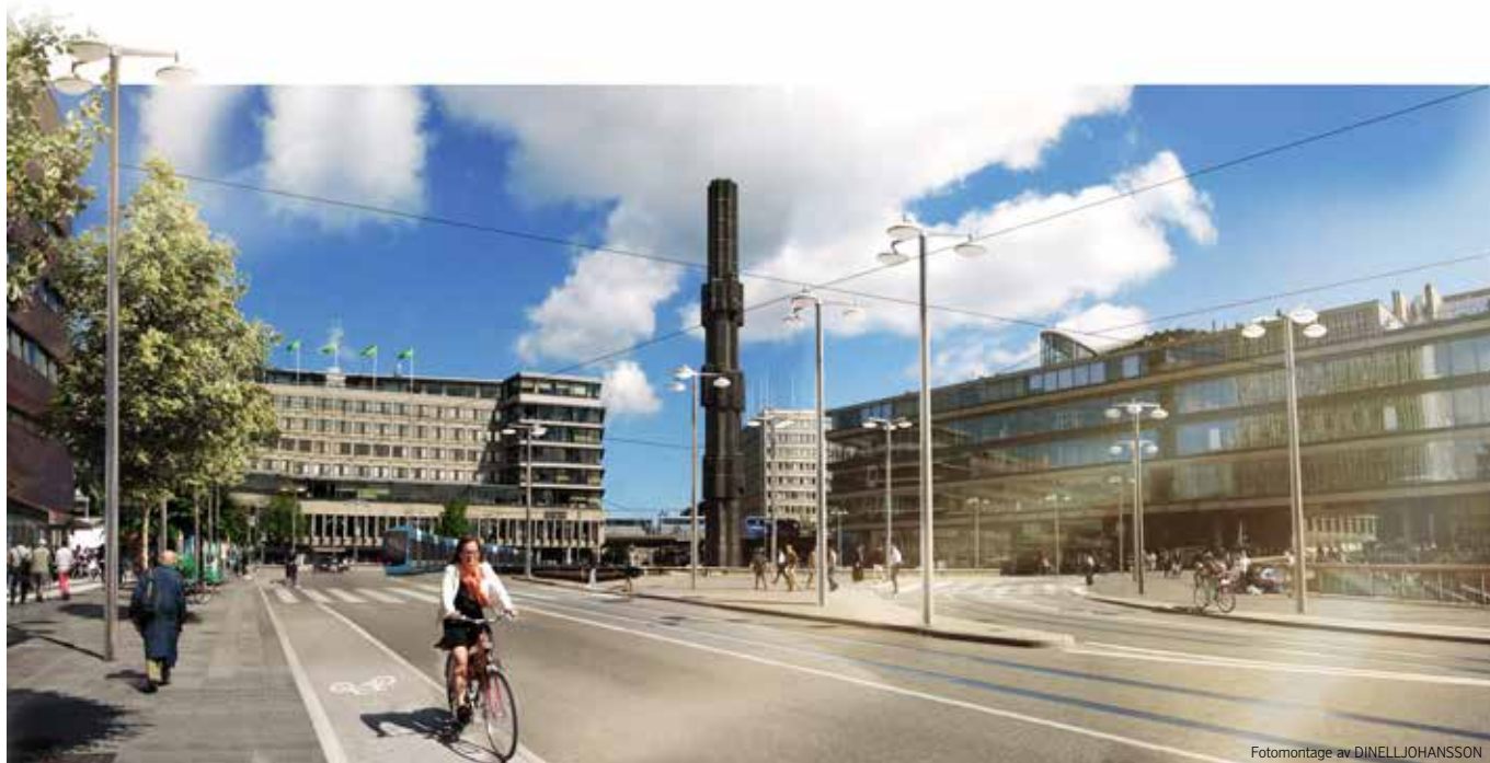
Illustration av förändrade belysnings- och kontaktledningsstolpar samt kontaktledning vid Sergels torg. Bildens visar även hur kontaktledningens bärlinor fästs i stolpar samordnat med belysningen
