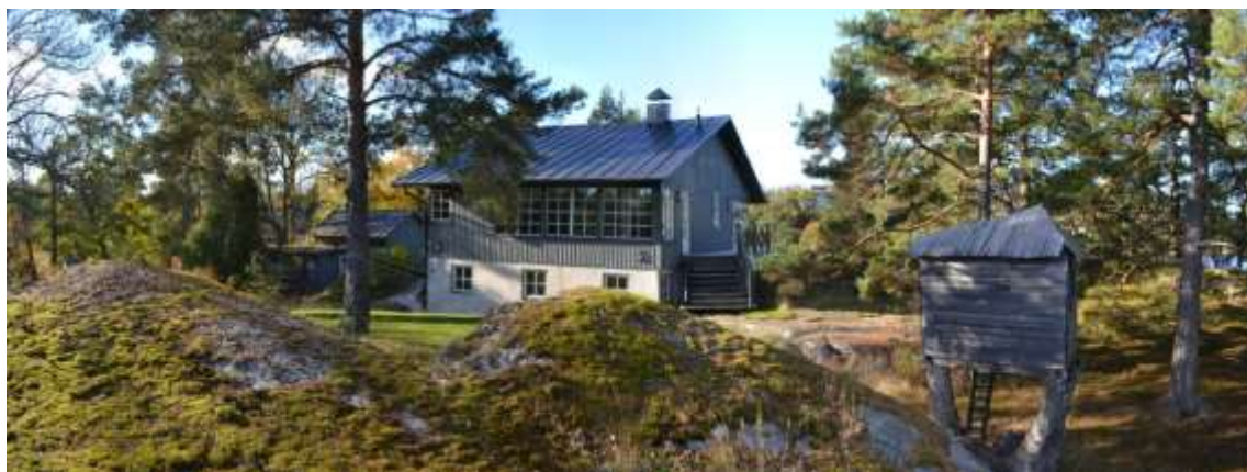
Figur 5. Byggnaden skymms delvis av bergknallen på östra sidan av udden.
