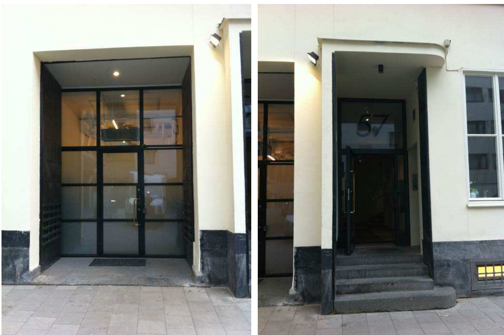
Bevarade kopparklädda originalportar.
