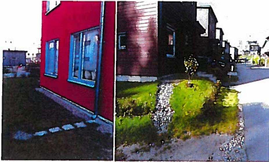
Figur 9. Exempel på utkastare och avledningsstråk från bostadhus.
