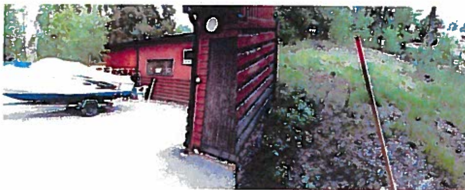
Figur 7. Takvatten avleds direkt till mark.
