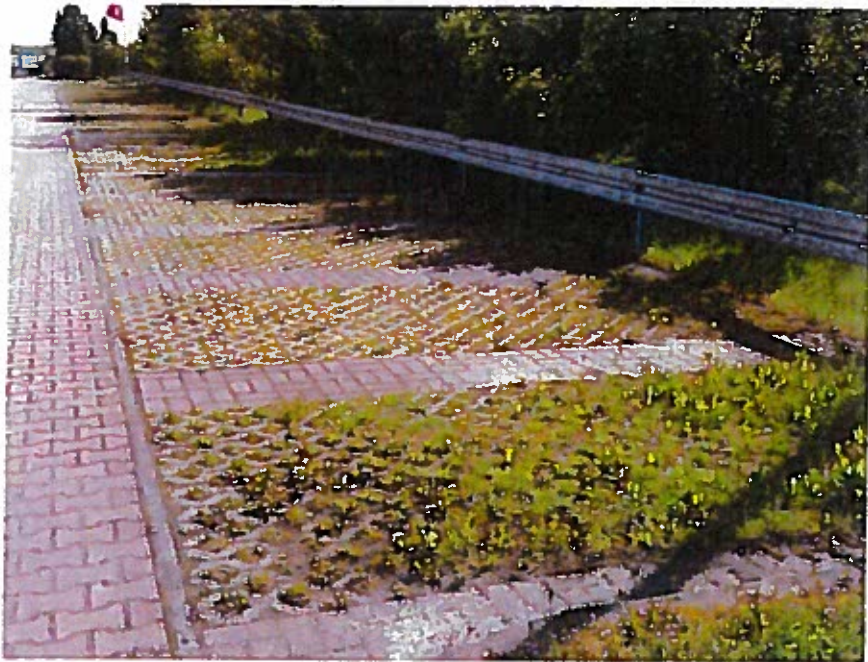
Figur 12. Infiltrerbara, gröna parkeringsrutor utformade med betonghålsten.
