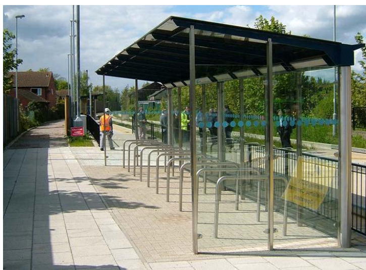
Figur 20: Cykelparkering med ramlåsning, väderskydd och belysning vid hållplats. Källa: www.framtidenskollektivtrafik.se
