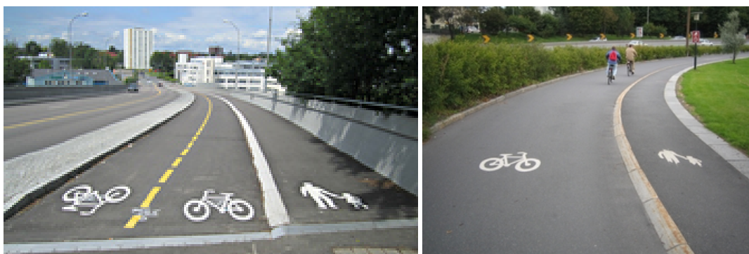
Figur 8 (vänster): Dubbelriktad cykelväg i Oslo, 3 meter bred cykelväg och 2 meter gångbana. Källa: http://www.bymiljoetaten.oslo.kommune.no/
