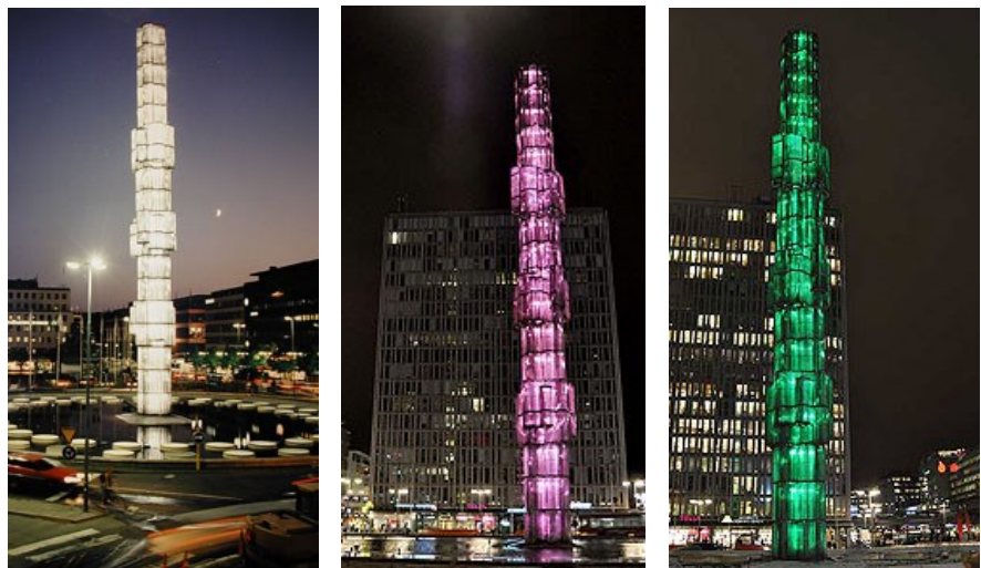
Nuvarande belysningsanläggning i vitt, rosa och grönt
