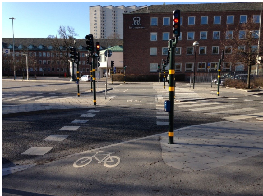
Bild: Övergångsställe vid Västerbroplan efter ombyggnad
