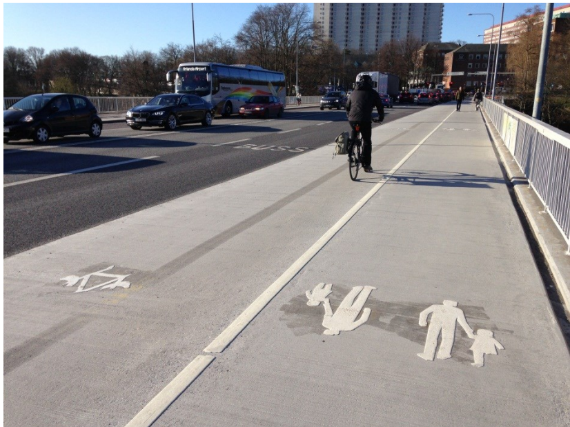
Bild: Efter ombyggnaden, cykelbana 2,75m och gångbana 2,25m Övergångsstället vid Västerbroplan byggdes om för att anpassas till den bredare cykelbanan. Trafikljusen utökades med en ytterligare grönfas under ett omlopp vilket gör att gående och cyklister får grönt fortare.
