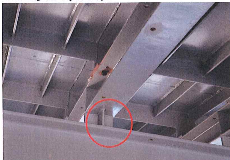
Bild 5: Farbanans bärverk svetsad till långbalk
