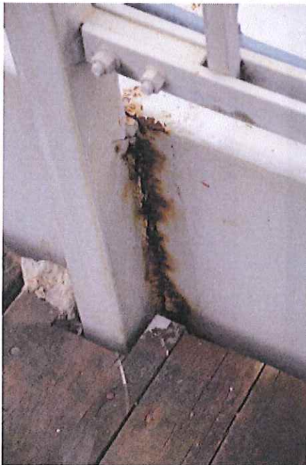
Bild 2: Rostig räckesinfästning.
