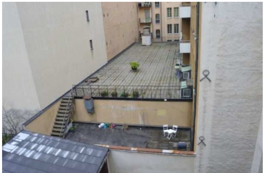
Gårdsmiljö, sedd från Sjökalven 17. Överbyggd gård i två nivåer på Sjökalven
