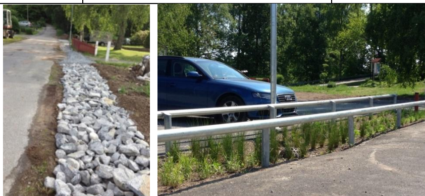
Figur 10. Krossmaterial/ grönyta som kan läggas vid parkeringsytor.
