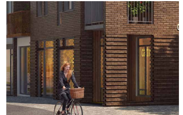
Detaljering i tegelfasad i sockelvåning
