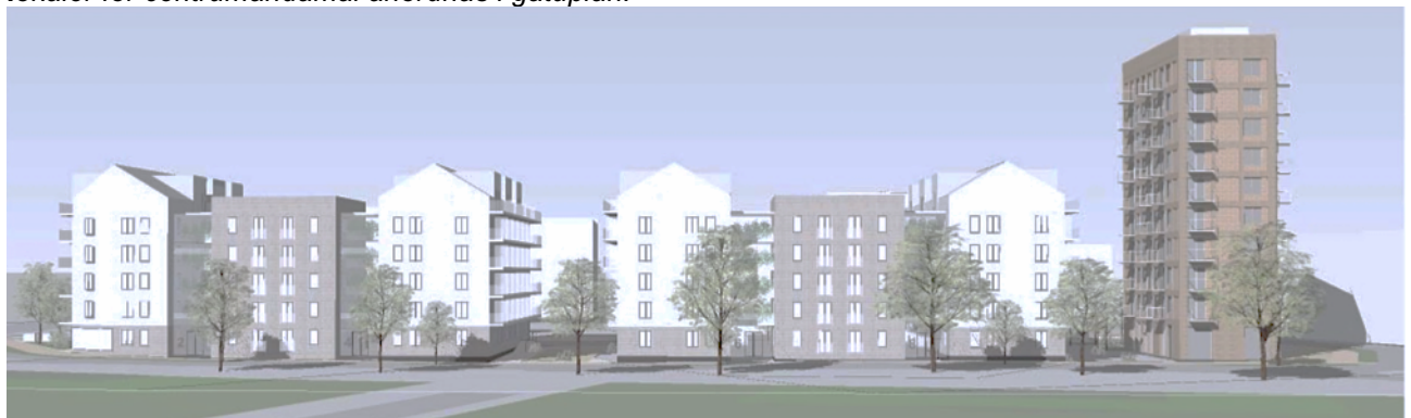
Bild som illustrerar hur kvarteret kan se ut från Bollmora allé. De olika byggnadsvolymer ska ge ett varierat uttryck i form av olika byggnadshöjder, placering i avstånd mot gatan och taktyper samt sadeltak på gavlarna.
