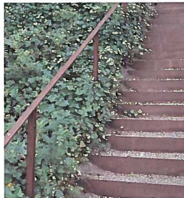
Trappar och handledare i stål.
