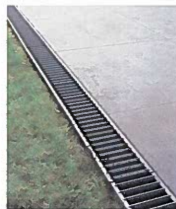
Aco drän t. ex. vid garage.
