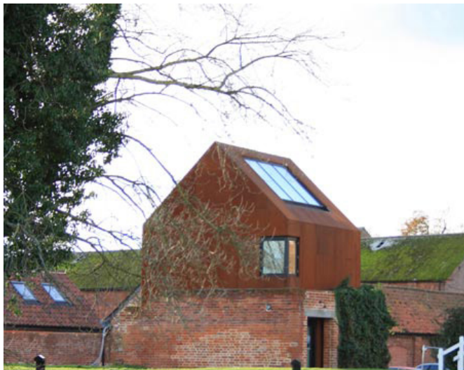
Stora takfönster (Howard Tomkins).
