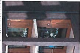
Indragen balkong med träfasad
