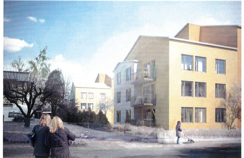
Västra kvarterets södra del sett från Slättvägen
