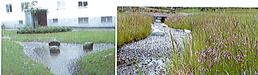
Figur 11. Öppet avvattningsstråk/översvämningssyta. (bild från Svenskt vatten P105 och Veg-Tech)
