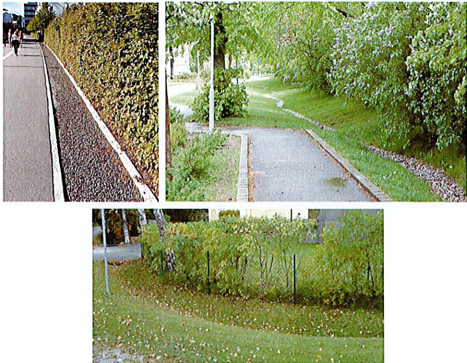
Figur 7. Avrinning i krossdike, svackdike med och utan dränerande botten.
