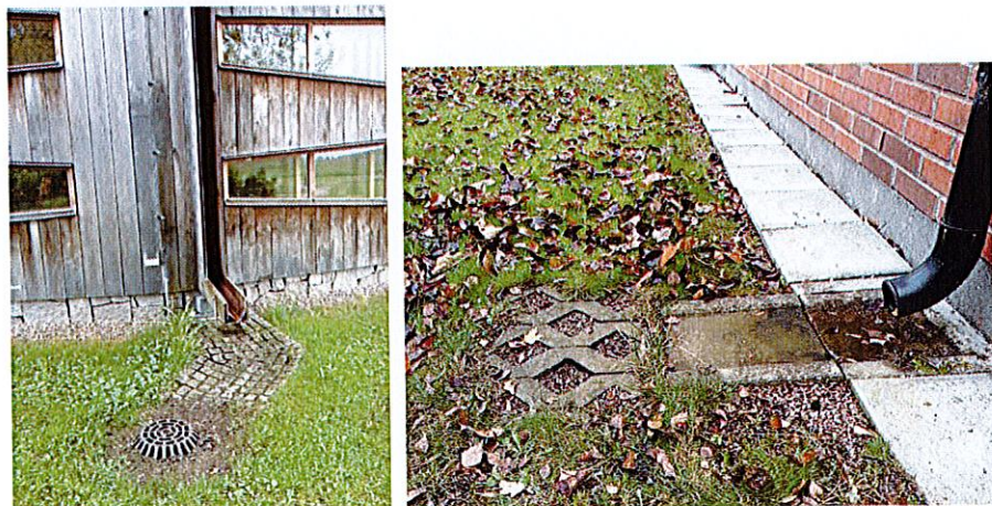
Figur 6. Utkastare till dagvattenbrunn respektive infiltration.
