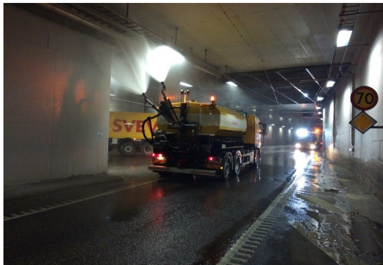
Tunneltvätt i Söderledstunneln
