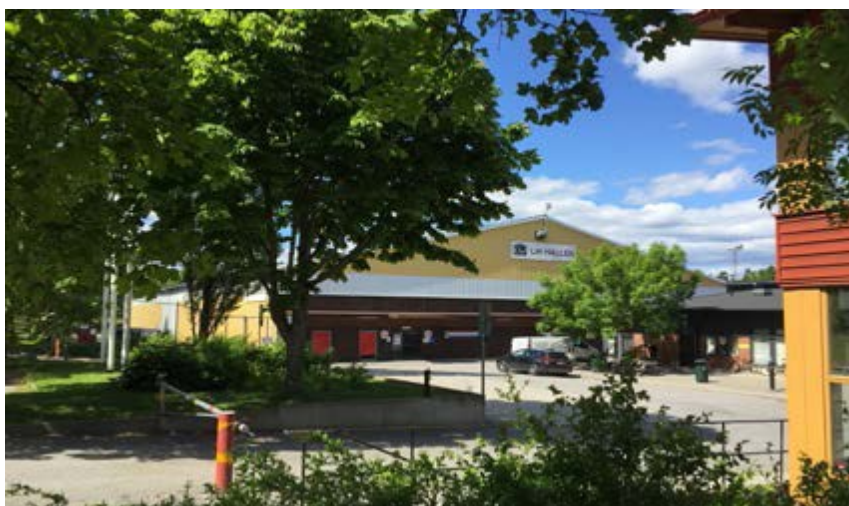
Sättra IP exteriört befintlig hall.
