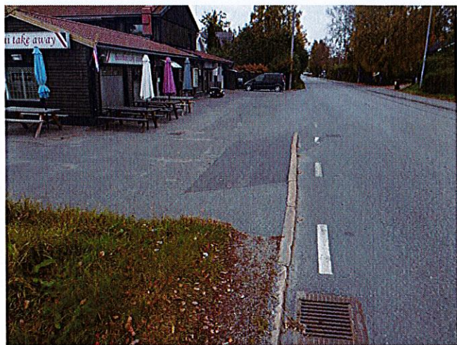
Bild 4. Restaurang längs med Kärrvägen. Anslutning till dagvattenanläggning sker via gallerbrunnar på parkering och i gata.
