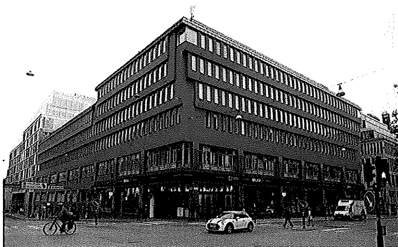
Befintlig byggnad (foto: Nyréns)
