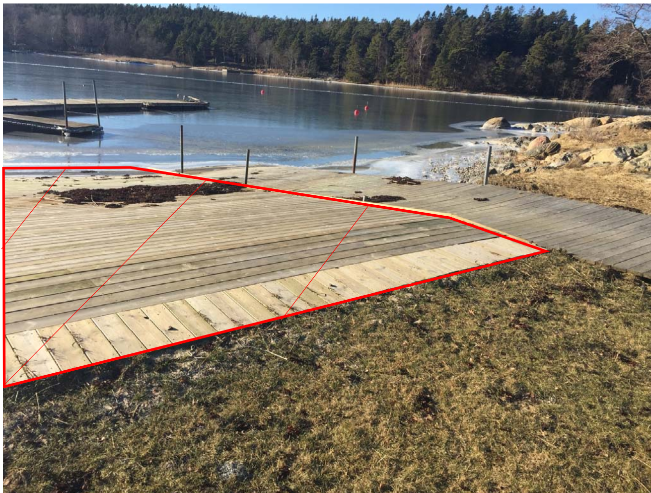
Föreläggande bilaga, bild 2. Tillbyggd jolleramp, markerat med rött, som enligt föreläggande ska tas bort.
