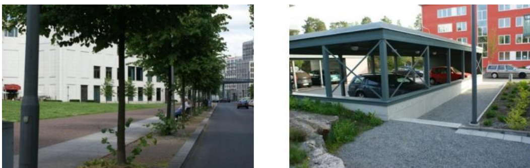
Figur 14. I vänstra bilden visas ett grusat respektive betongsatt gångstråk. Till höger visas exempel på markbeläggningar som ökar genomsläppligheten och som kan användas för gång- och cykelstråk.
