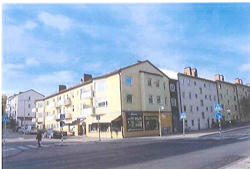
Låga lamellbyggnader vid Skärlingebacken. Bild: Tyréns
