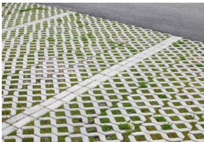
Figur 14. Hålsten/betongraster med gräs på parkering i Växjö. Foto: Sweco
