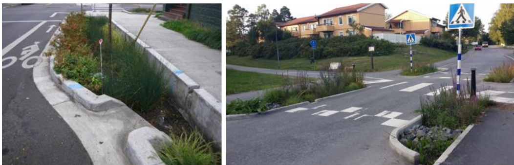
Figur 15. Exempel på Regnbäddar/Växtbäddar i gatumiljö. Foto: Sweco.
