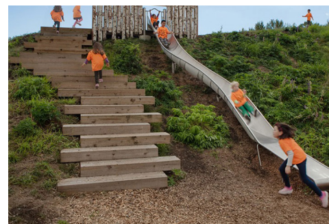
105. Rutschlek med trappsystem av slipers.
