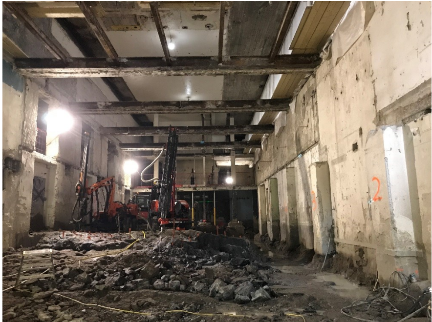
2 Bergspräckning i västra flygelns källare
