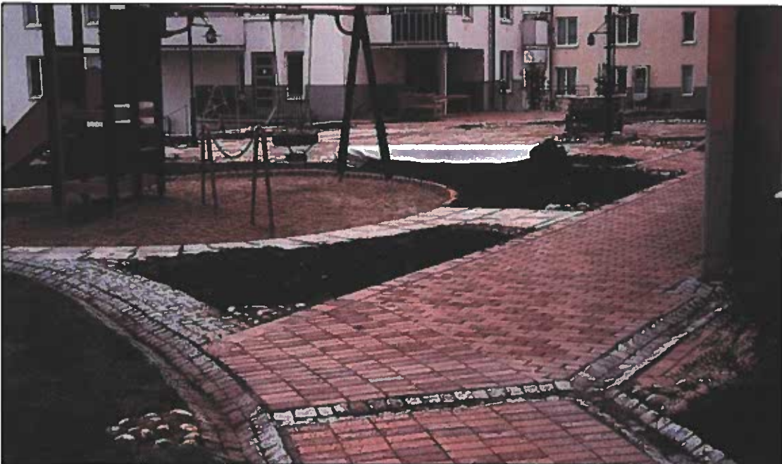
Figur 5-2. Exempel på avledning av takvatten via rännalar anlagda med gatsten (Källa: Stockholm Vatten AB, n.d.).
