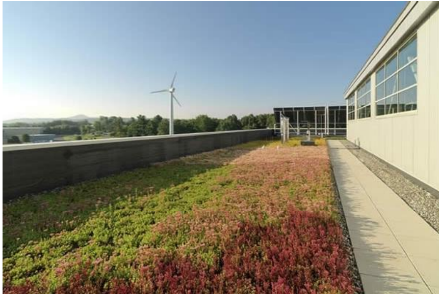
Referens. Sedumtak med uppdragen sarg.
