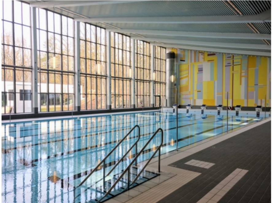
Bild 4. Gamla 25-metersbassängen, renoverad
