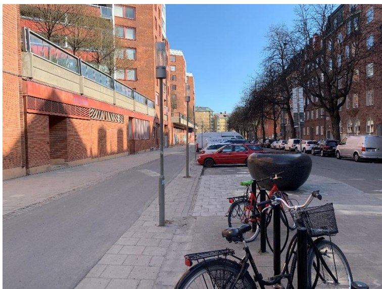
Figur 4. Bild på den ombyggda gång- cykelbanan vid Fältöversten.
