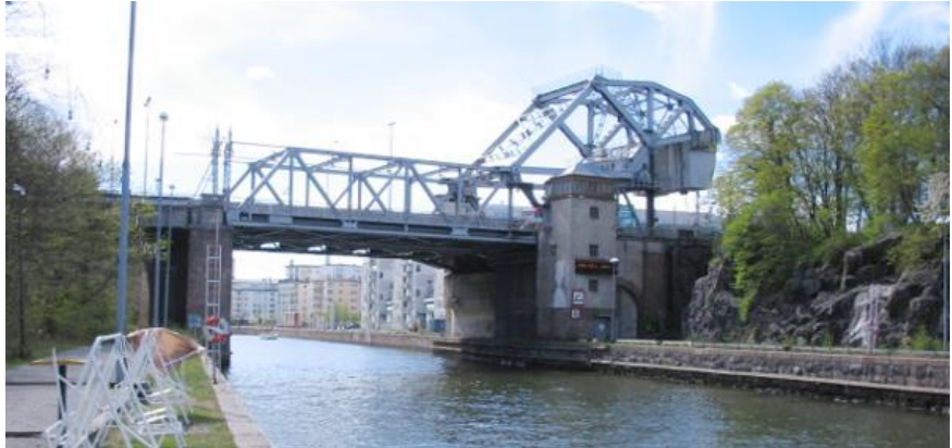
Bild 1. Befintlig bro/utseende efter Totalrenoverad bro.
