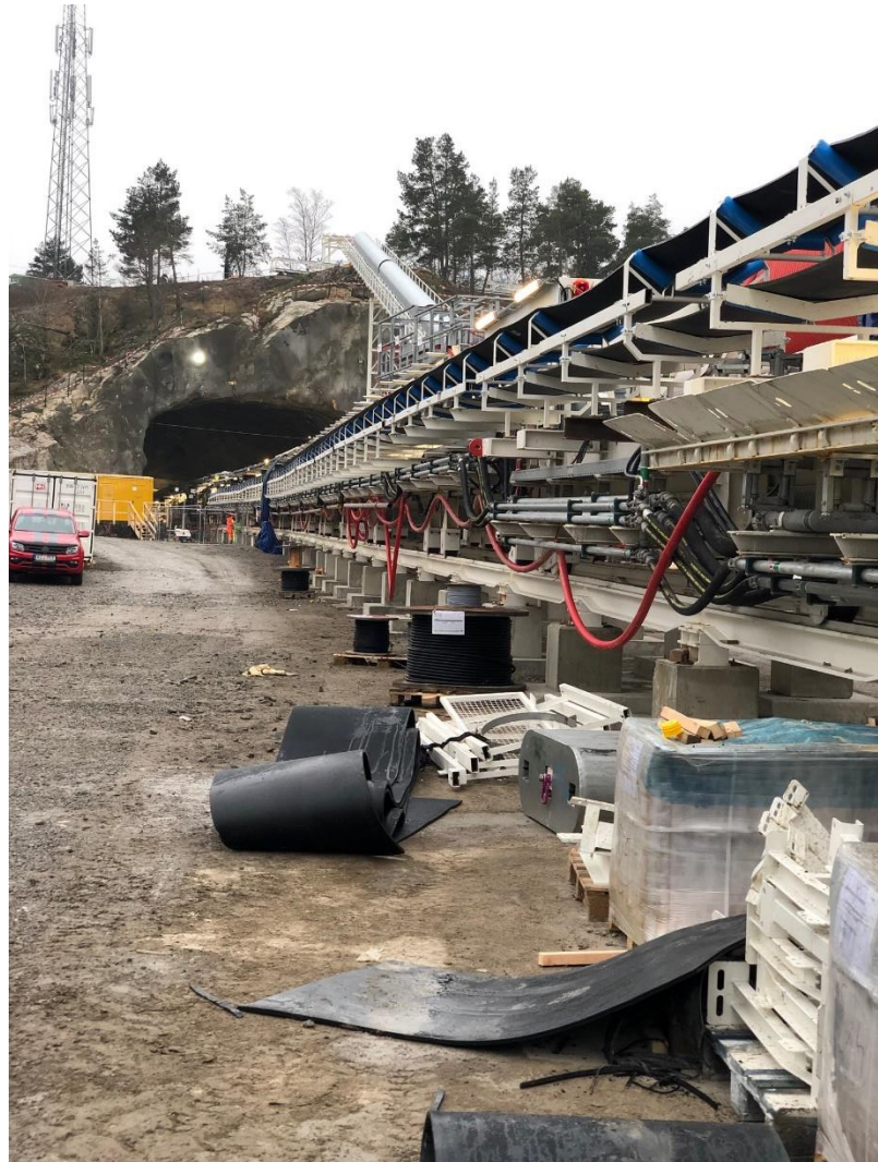
Bild 1: TBM borren vid Anneberg, Danderyd . Borrhuvud går in i berget på bilden. Massorna transporteras bakåt på transportband som byggs ut vartefter framdrift sker. Man har också mindre förborrar för injektering innan man borrar själva tunneln framåt. Utrustningen drivs med el.
