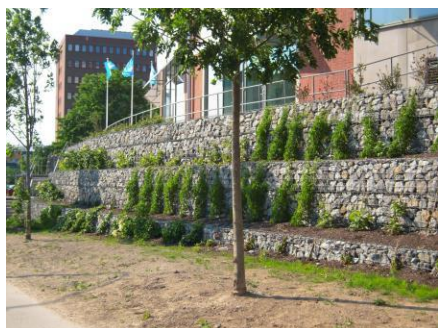
Exempel på gabionmur.
