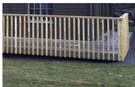
Referens träräcke, utförs med så smala träribbor som möjligt. Med behandling av ex. järnvitrol Bild: Sundell Arkitekter AB
