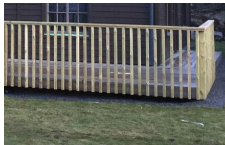
Referens träräcke, utförs med så smala träribbor som möjligt. Med behandling av ex. järnvitrol Bild: Sundell Arkitekter AB
