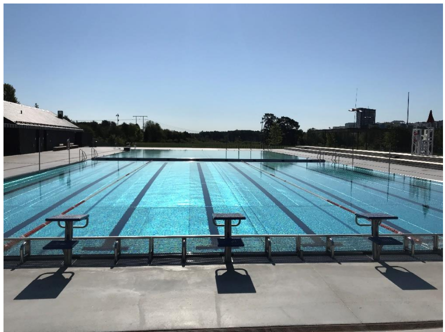
Stora bassängen delad i två delar med olika bassängbottendjup och fast vägg
