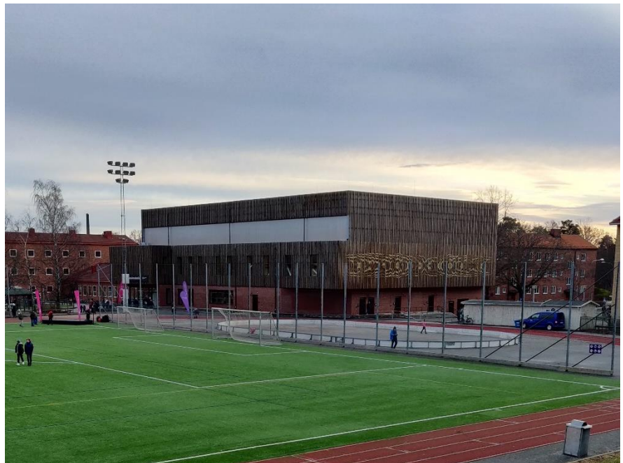
Figur 2, Vy från läktaren på Västberga IP.
