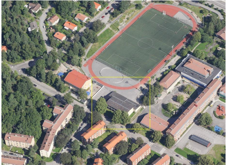
Figur 1, Vy över Västberga IP med den gamla gymnastiksalen som revs i juni 2017.
