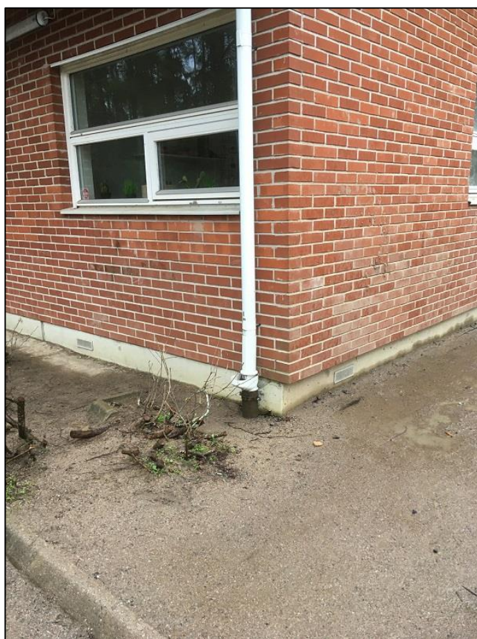
Figur 5. Stuprör från byggnadens tak är kopplat direkt till ledningsnät. Foto: WRS (200129).
