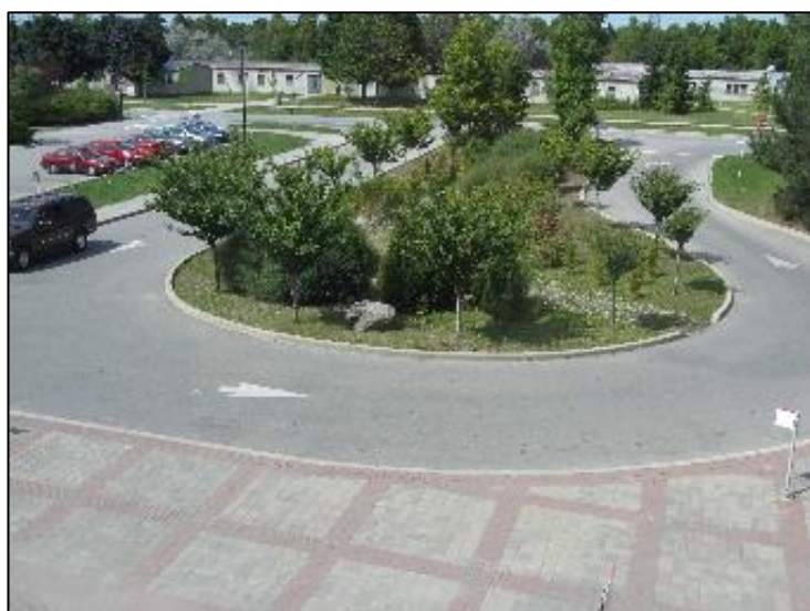
Figur 17. Exempel på fördröjning av dagvatten från parkering och köryta. Foto: (NRWA)
