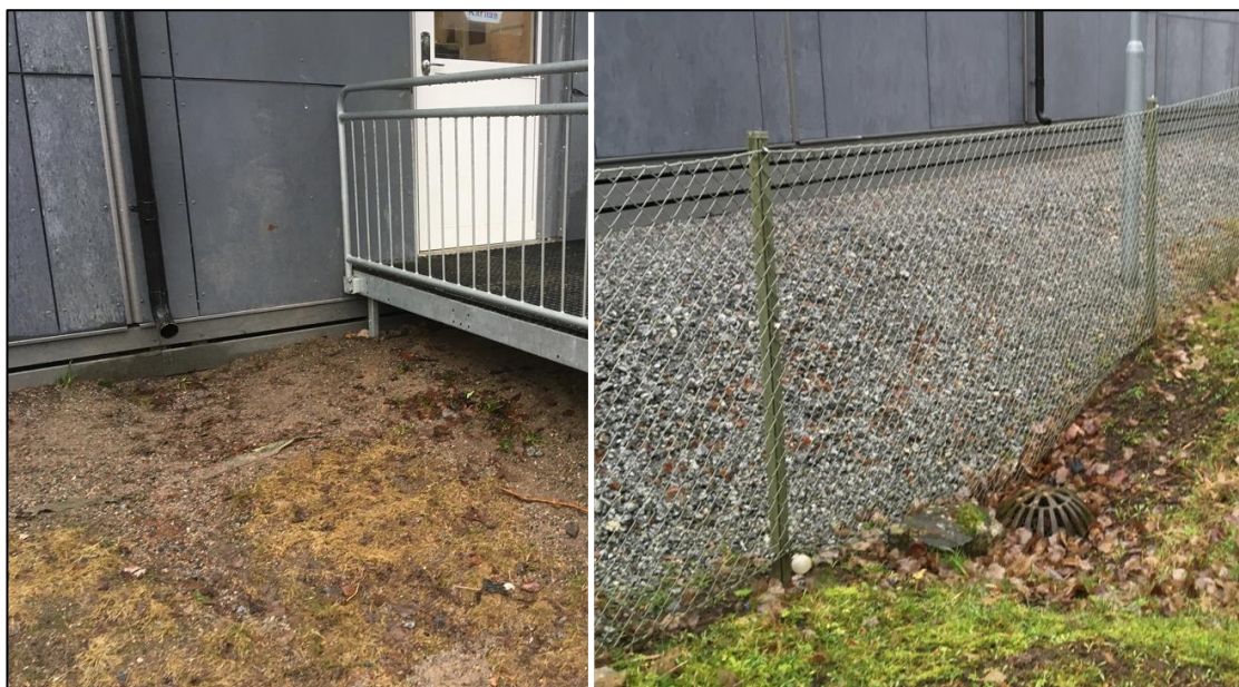
Figur 6. Bilden till vänster visar takvatten från provisoriska paviljonger som rinner mot förskolegården via utkastare. Bilden till höger visar dagvattenbrunn på baksidan av paviljongerna vid gc-vägen söder om planområdet. Foto: WRS (200129).
