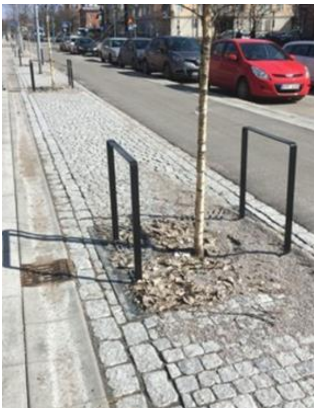
Figur 25. Exempel gatuutformning och träd i skelettjord på Strandbodgatan i Uppsala. Foto WRS AB.
