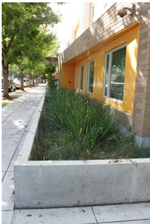
Figur 15. Bildexempel på upphöjd växtbädd längs en husvägg. Bild: WRS.
