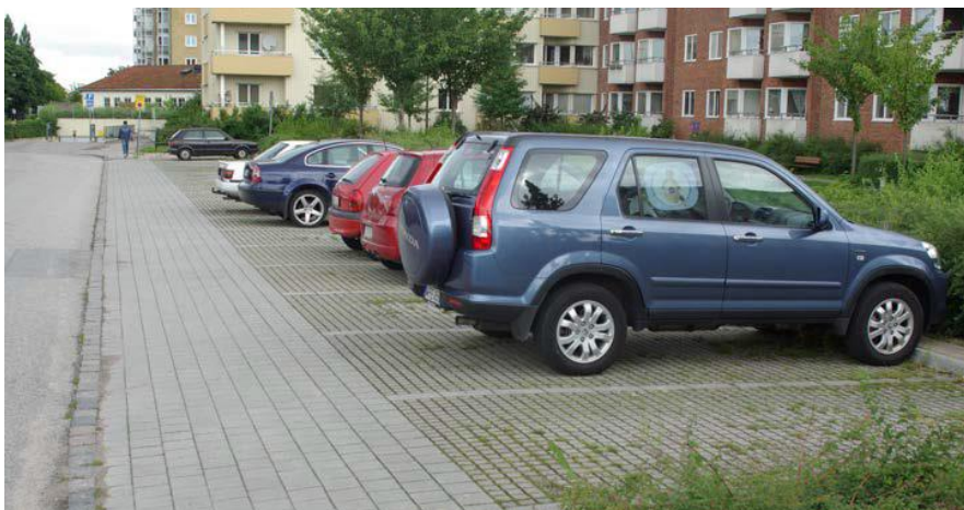
Figur 23. Exempel på parkering med genomsläpplig beläggning. Foto WRS AB.
