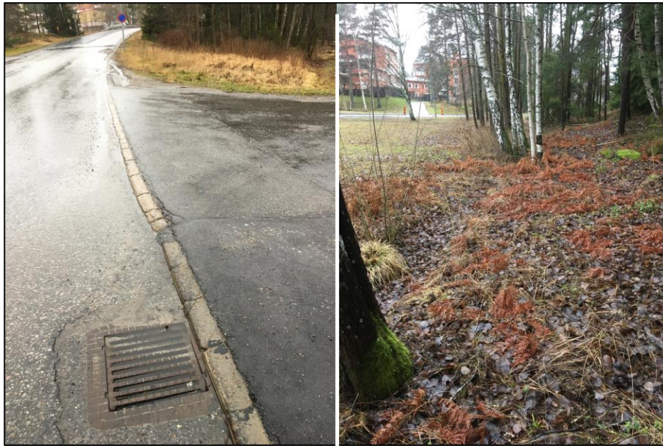
Figur 8. Bilden till vänster visar den översvämmande dagvattenbrunnen i Farmarstigen, fotograferad från norr vid infarten till förskolan. Bilden till höger visar skogsslätten väster om planområdet där det idag går ett grunt dike i släntfoten. Foto: WRS (200129).
