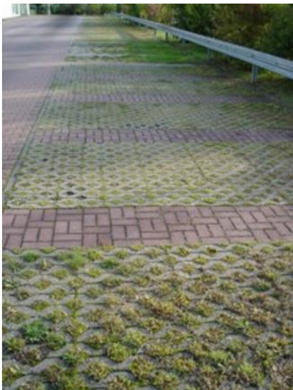
Figur 16. Hålstensbeläggning på parkering Foto: WRS AB
