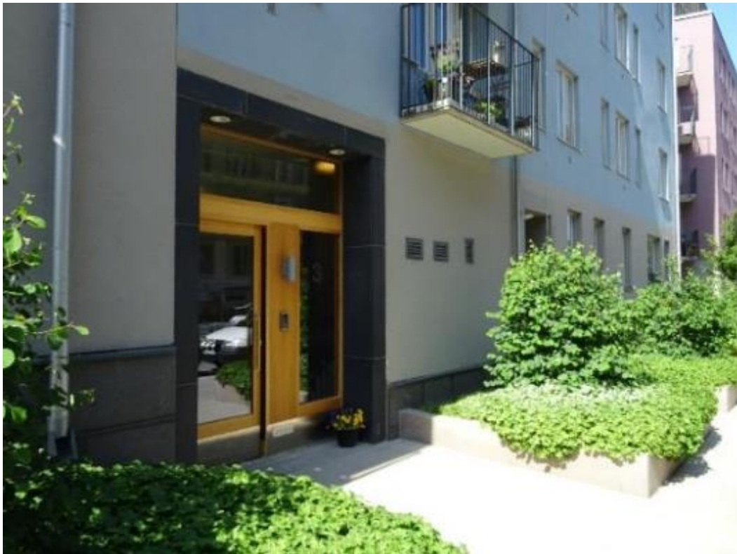
Figur 21. Exempel på regnbäddar för takvatten typ förgårdsmark, Stockholm. (Nacka kommun, 2018).
