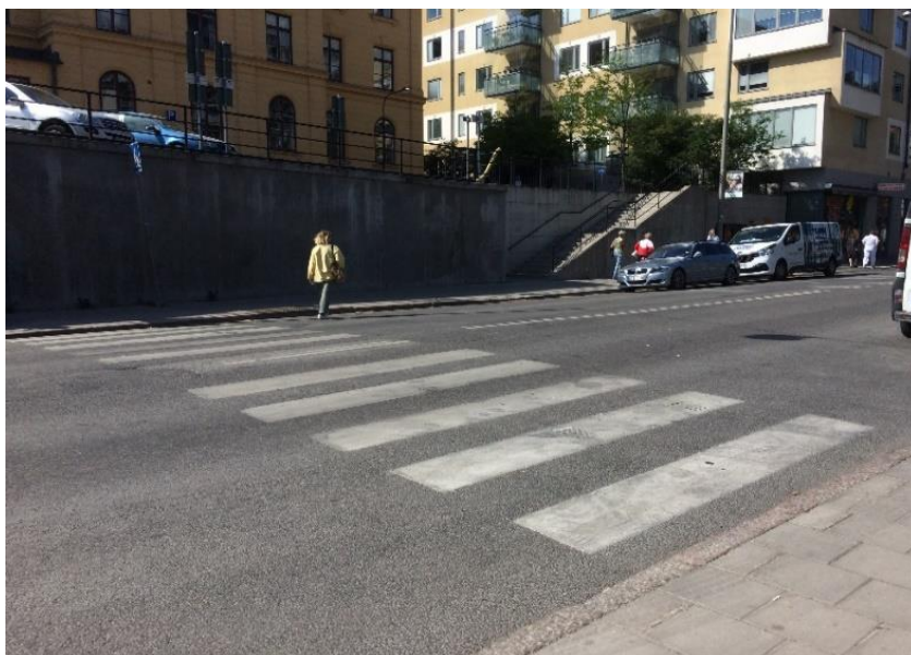
Figur 6. Övergångsstället på Mariebergsgatan vid sjukhemmet saknar refuger och tillgänglighetsanpassningar.
