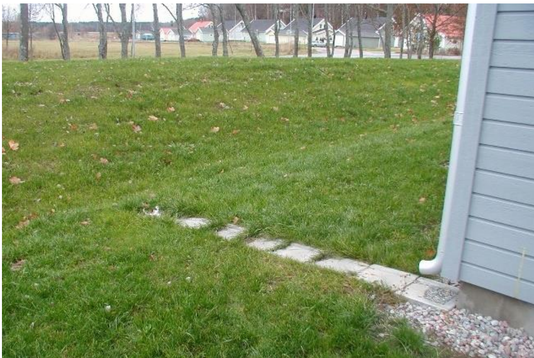
Figur 8. Exempel på takvatten som avleds via utkastare och rännal till mindre gräsmatta vidare mot lågområde/svackdike. Notera att marken sluttar bort från husen. Foto: WRS
