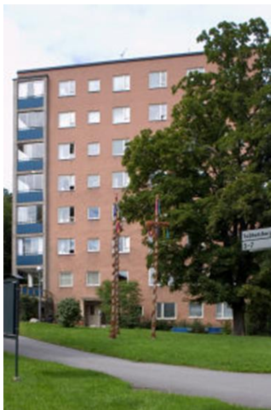
Grötlunken 2 norra fasaden
