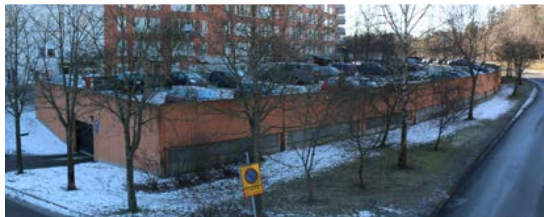
Befintlig garagebyggnad i betong blåstras så att betongens yta och kulör framträder.
