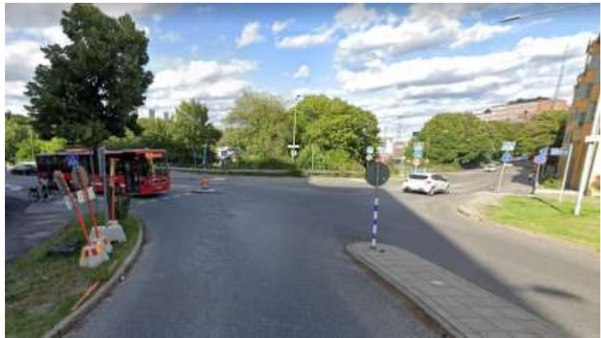
Figur 6. Kilabergsvägens korsning med Tellusborgsvägen
