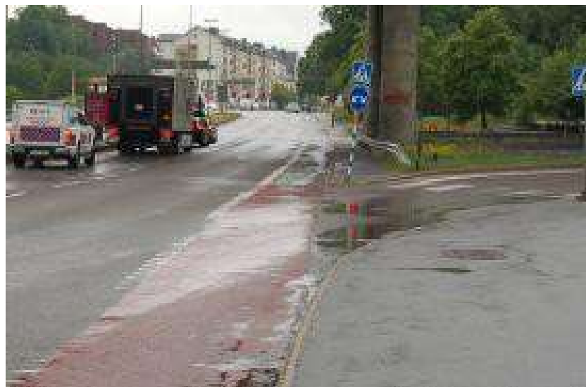
Figur 3. Generös svängradie för motorfordonstrafik över cykelpassage vid Essingeledens påfart medger höga hastigheter.
